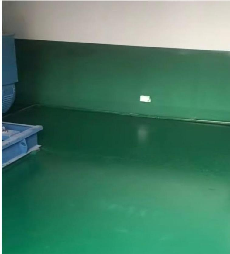
图 4.1-15 项目柴油发电机房防渗措施照片
