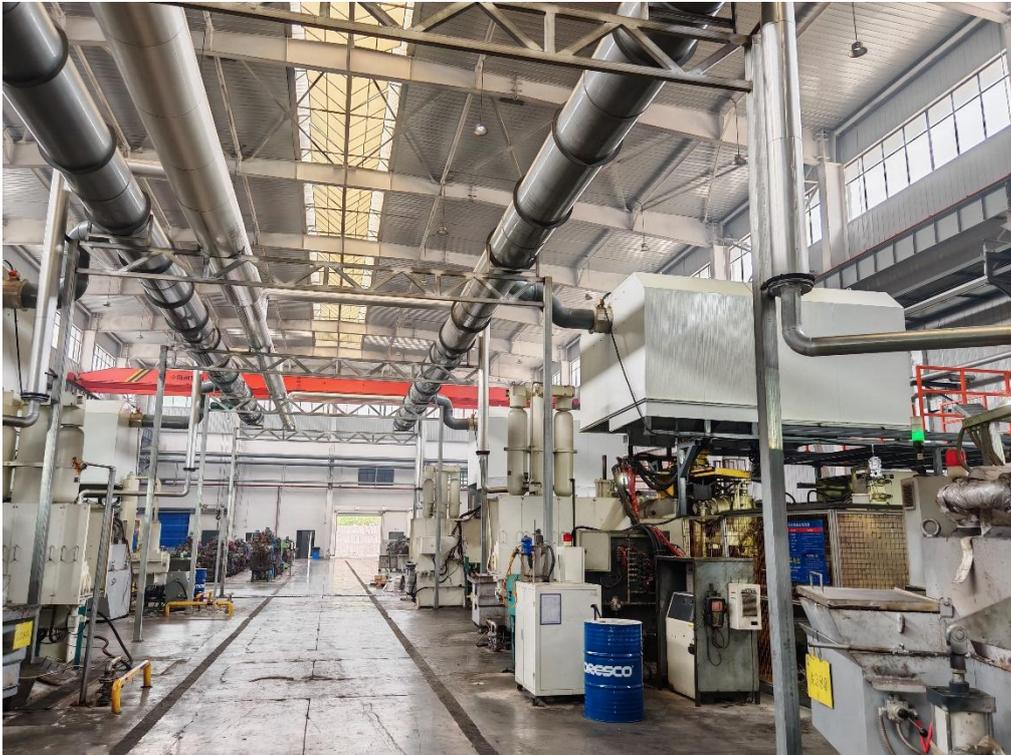
图4.1-4 压铸工序脱模废气收集照片
