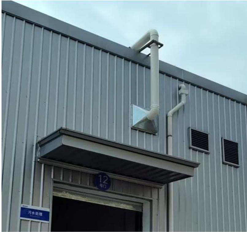
图 4.1-8 污水处理站臭气收集后屋顶排放照片
